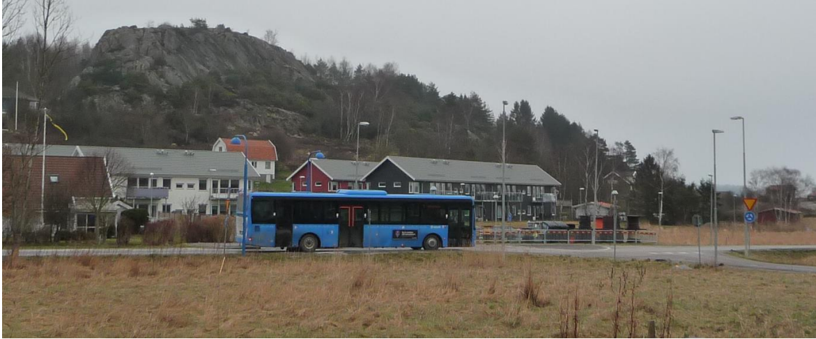
Figur 5. Nybyggda hastighetssäkrande åtgärder längs Höviksnäsvägen i form av avsmalning vid övergångsställe och liten cirkulation.
