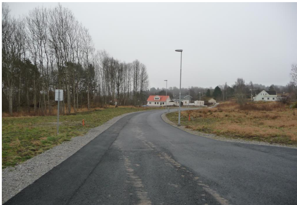
Figur 8. Den nybyggda gatan precis öster om planområdet. Planerade bostadshus längs denna gata är ännu inte byggda. Vissa andra hus i området är just färdigbyggda eller håller på att byggas.
